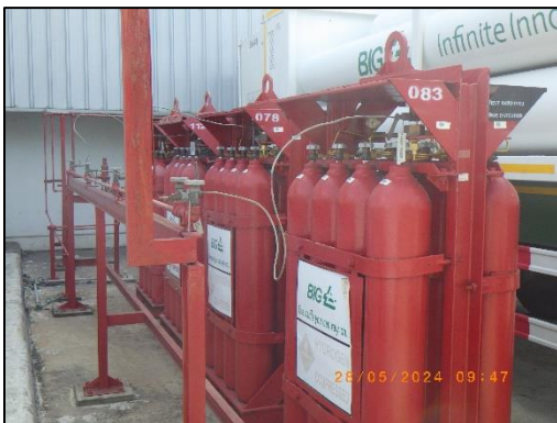
รูปที่ 3-45 การจัดเก็บแก๊สไฮโดรเจน และแก๊สไฮโดรเจนสำรองในพื้นที่ที่มีอากาศถ่ายเท
