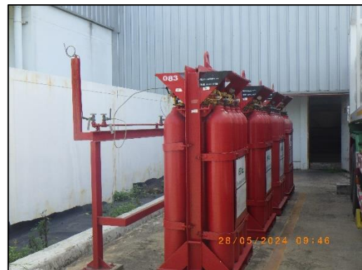
รูปที่ 3-45 การจัดเก็บแก๊สไฮโดรเจน และแก๊สไฮโดรเจนสำรองในพื้นที่ที่มีอากาศถ่ายเท
