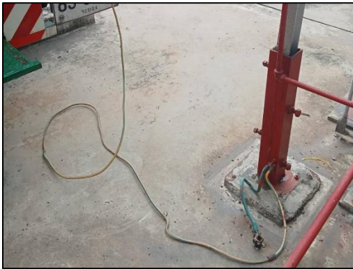
รูปที่ 3-48 ระบบสายดินบริเวณกักเก็บก๊าซไฮโดรเจน
