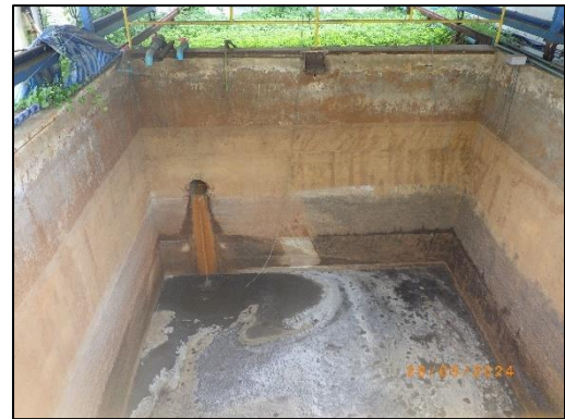
รูปที่ 3-7 ถังรวบรวมน้ำเสีย (Storage Tank) ขนาด 30 ลูกบาศก์เมตร
