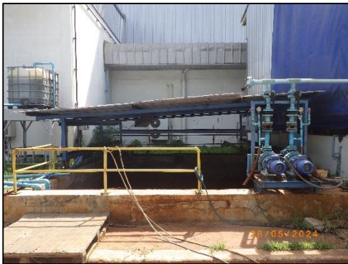
รูปที่ 3-7 ถังรวบรวมน้ำเสีย (Storage Tank) ขนาด 30 ลูกบาศก์เมตร
