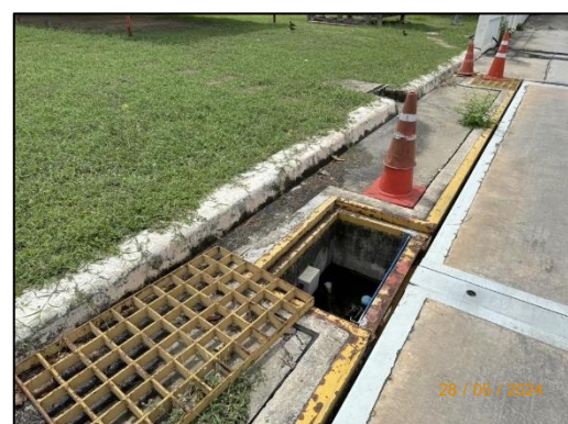
รูปที่ 3-15 การตรวจสอบและทำความสะอาดรางระบายน้ำฝน
